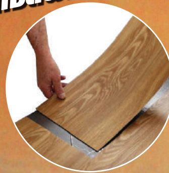
เทพรับผิวพื้นคอนกรีตให้เรียบ ขึ้นก่อนปูกระเบื้องไวนิล
