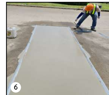
ถ้ารอยร้าวเล็กลงให้เจียรผิว เฟอร์โรกรีต 216 ที่หลุดลงเทออกและตัดเส้นใจเททับทั้งแผงได้
