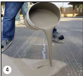
เททับรอยซ่อมเล็กน้อยด้วย เฟอร์โรกรีต 216 ทิ้งแห้ง 6 ชม.
