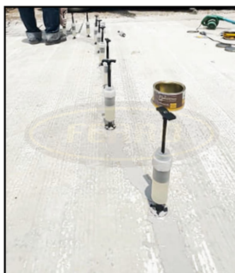
ฉีดยึดซ่อมรอยร้าวด้วยชุดอีพ็อกซี ฉีดยึดซ่อมรอยแตกกร้าวคอนกรีต (เฟอร์โรเรซ 717/คิท)
