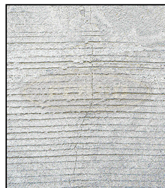
หลังเททับด้วย เฟอร์โรกริต 216 ทำให้รอยร้าวมีขนาด เล็กลง
